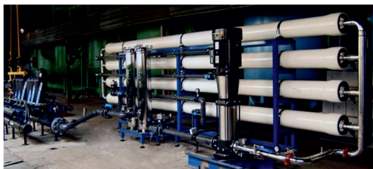
ОБЩИЙ ВИД ОБОРУДОВАНИЯ ДЛЯ НАНОФИЛЬТРАЦИОННОЙ ОЧИСТКИ ПОВЕРХНОСТНЫХ ВОД
