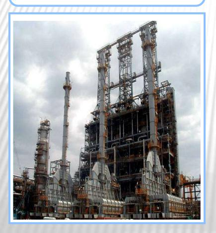
Проект включает строительство установки замедленного коксования, установки производства водорода, установки утилизации сероводорода "Клаус", установки сероочистки, реконструкция установок гидроочистки Л-24/7 и ЛЧ-24/7
