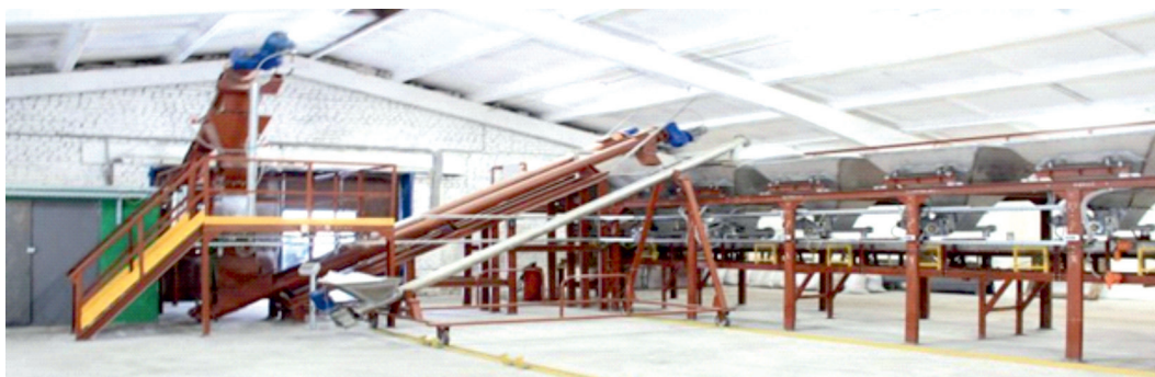
Установка по производству сорбента для птичника
